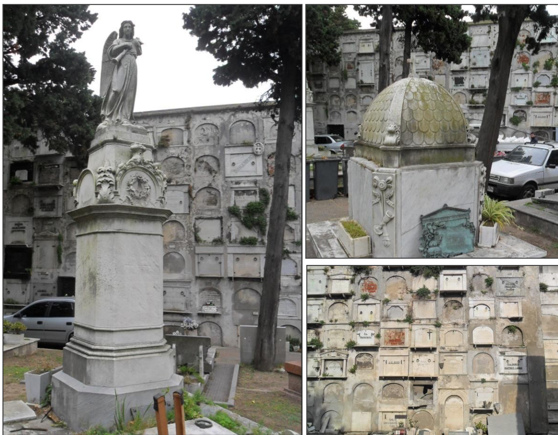
Figura 5. Vista general del frente de nichos afectados por el derrumbe
