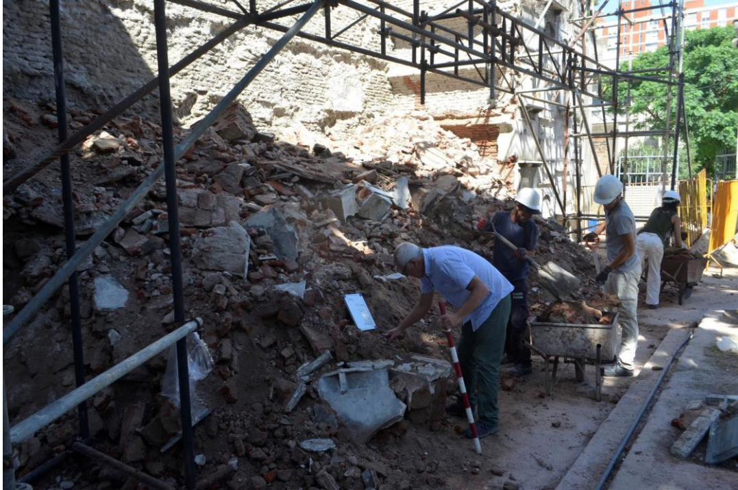
Figura 2. Excavación controlada del frente de escombrera y registro de hallazgos
